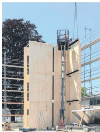
Mit Gerüst und Kran werden die 10 Meter hohen Elemente eingebracht. HÄMMERLE
